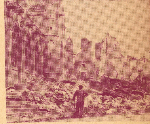
Les déblaiement d'une rue de Falaise.
